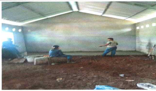
Foto 2: Iniciando el mejoramiento del piso de cocina del establecimiento.
