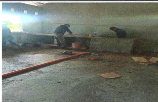
Foto 6: Iniciando con la de pila y mostrador
