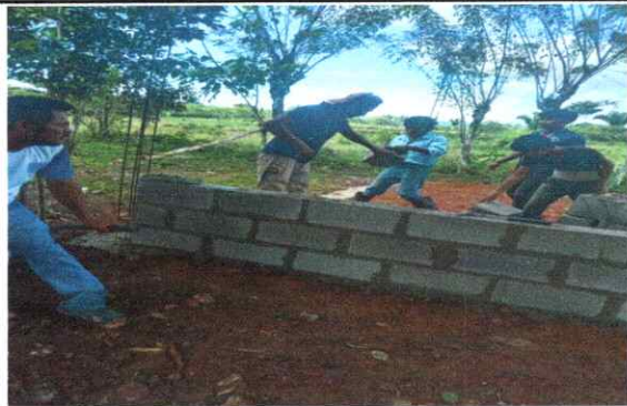
Foto1:Iniciando la Colocación de Block
