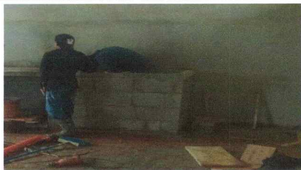
Foto 5: Iniciando la colocacion de la estufa.
