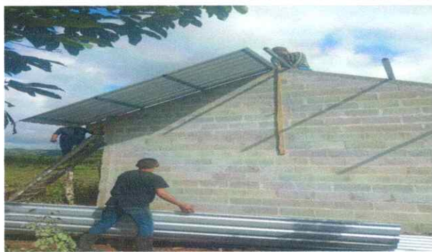
Foto 3: Se observa la colocacion del Techo
