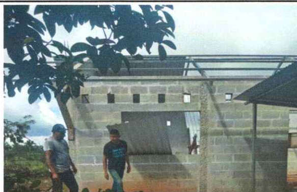
Foto 4: Se observa la reparacion del deterioro de la cocina.
